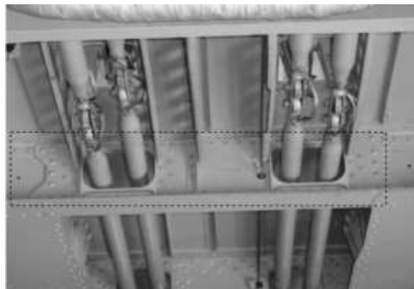
Рис. 2. Усиливающая ремонтная накладка на шпангоуте № 7 ЦЧФ
