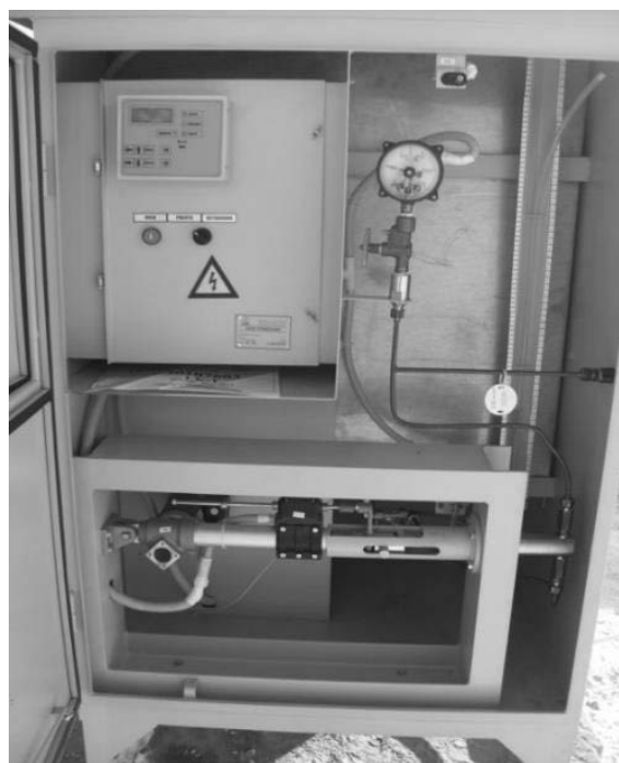
Рис. 7. Дозировочная установка с длинноходовым насосом и актуаторным приводом [1]
